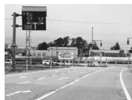
国道8号バイパス (古御堂～江口間)
