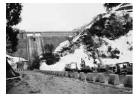
舟川ダム工事
