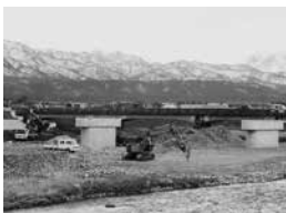
県道入善朝日線 (赤川橋の架け替え工事)
